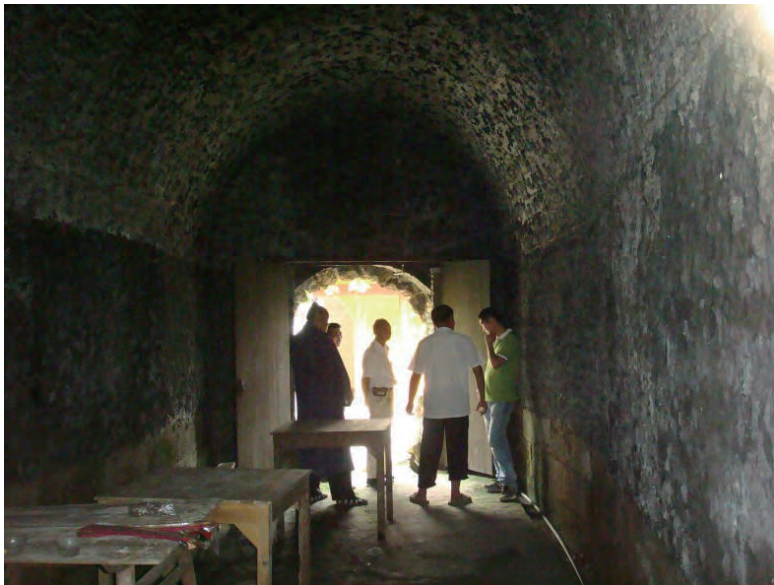
写真23 洞内から入り口を見たところ
