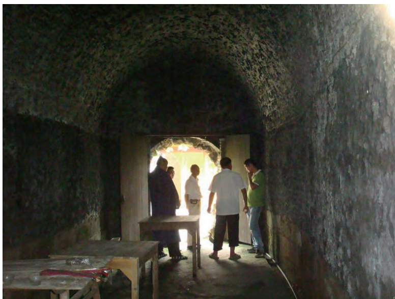
写真23 洞内から入り口を見たところ
