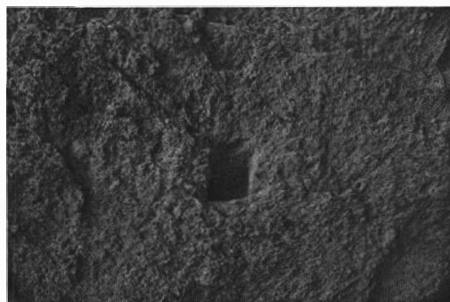
ホール部分に残る洞内工事の跡
