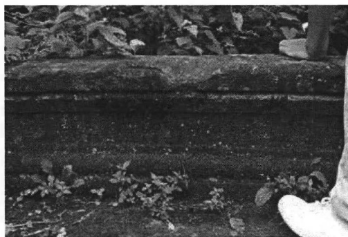
元同橋 建設年などが刻まれている
