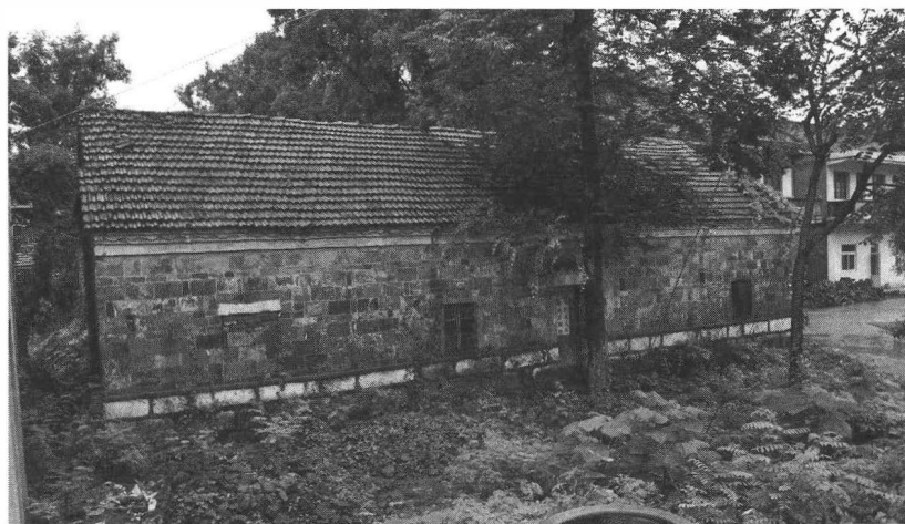
図 14 玉晨観跡地に立つ倉庫（建物は道観のものではない）
