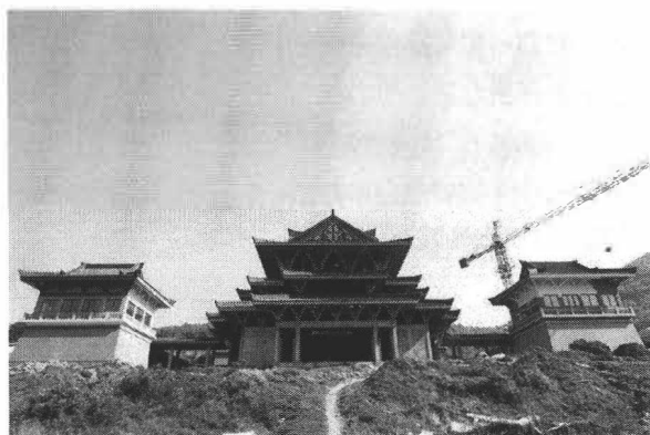
図12 建造中の崇禧萬壽宮の主殿と青鸞、白鶴閣の外景
